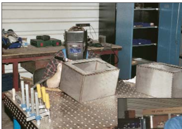
Bau einer lüftungstechnischen Einrichtung und Justierung einer Pilotanlage zur Luftentkeimung bei Air Solution
